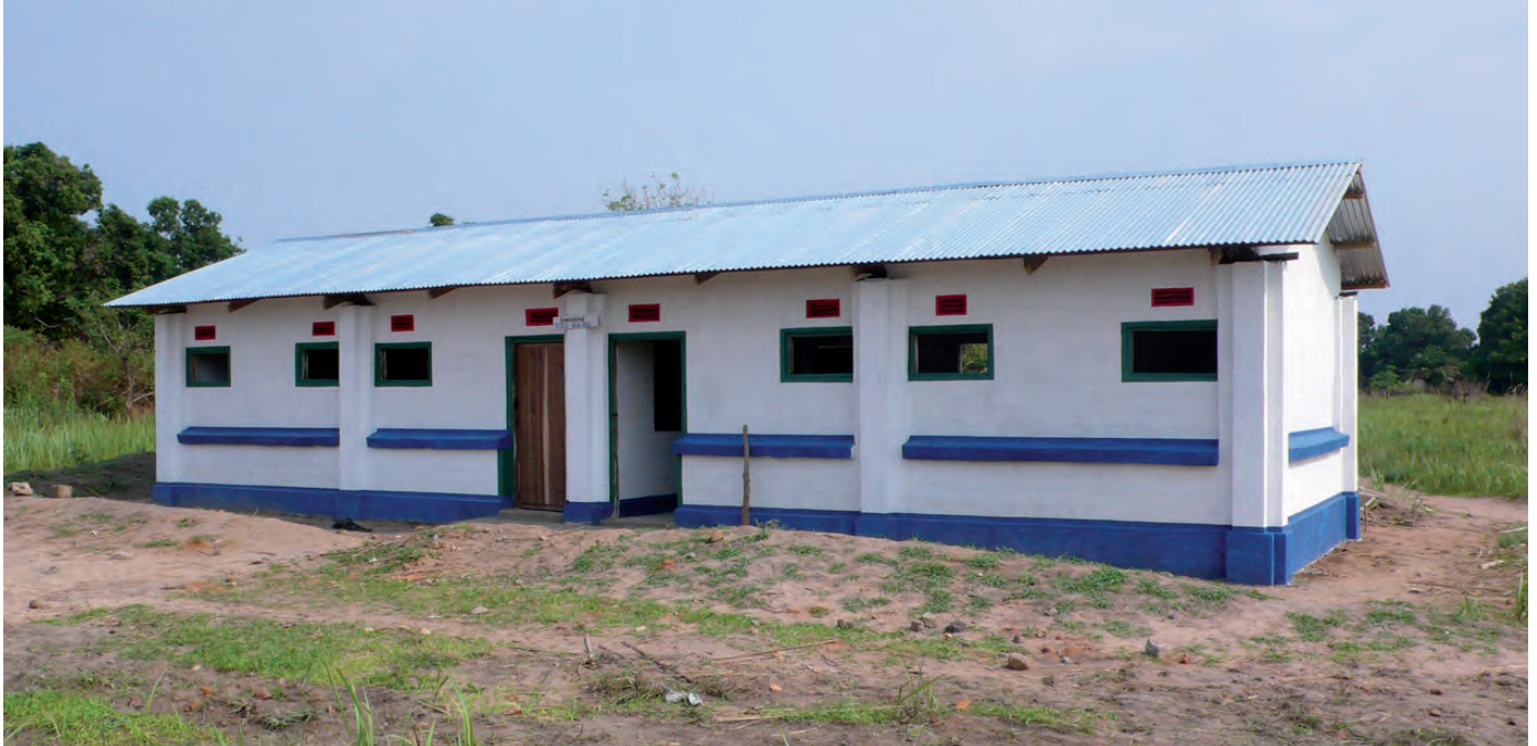
Figures 1 et 2. Vue d'une école construite dans le cadre du projet et de ses détails constructifs
