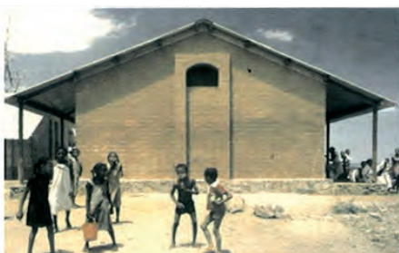
Ecole en ossature BTC
