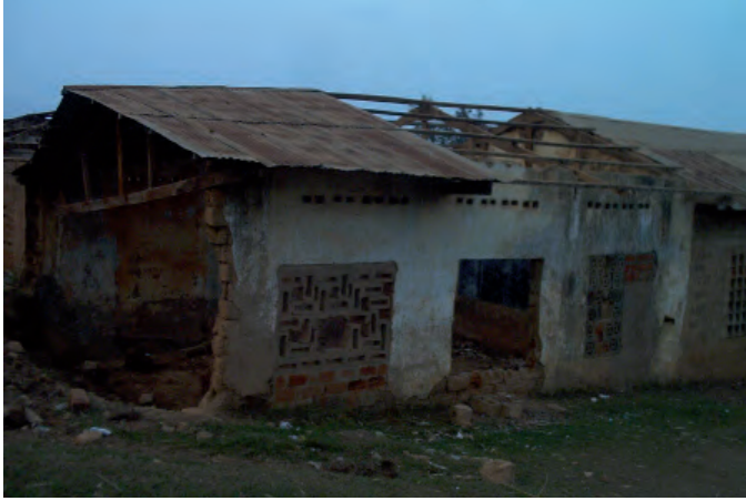
Figure 1. Ecole de Kingemba avant réhabilitation, dans la phase de démolage © Vital Ndele
