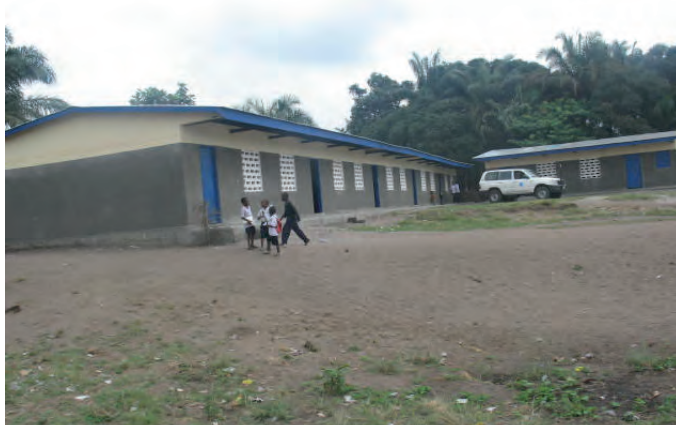
Figure 3. Ecole de Kwilu, nouvelle construction sur terrain vierge © Vital Ndele
