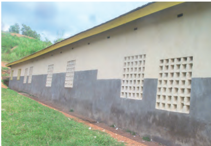
Figure 2. Ecole de Kingemba après réhabilitation © Vital Ndele
