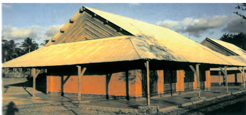
Ecole primaire en brique. 1986. Architecte Daudeville M et Hennion B.
