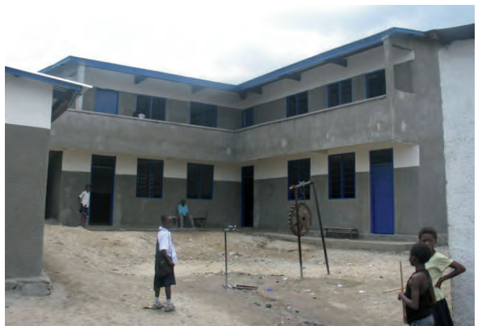
Figure 5. Ecole de Makala après réhabilitation © Vital Ndele
