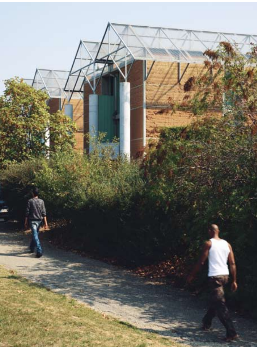
Le bâtiment des architectes Gilles Perraudin et Françoise-Hélène Jourda reprend le principe des hangars agricoles alentour. Sa compacité associée à un mur en pisé garantit un niveau de déperdition thermique minimal.
