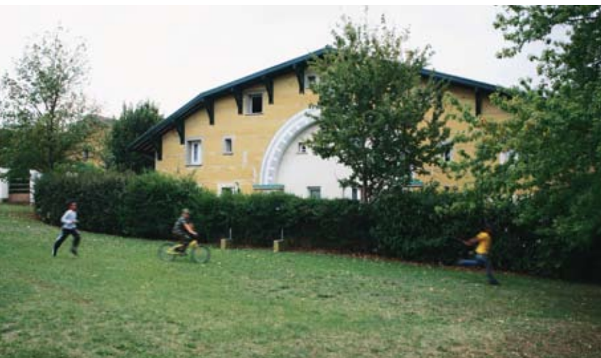
Cinq logements mitoyens en pisé, « fédérés » par une ample toiture réactualisant l'un des principes constructifs de l'habitat vernaculaire régional de la Beauce et de l'Isère. Architectes : Odile Perreau-Hamburger, J-M. Savignat et E. Monteau.
