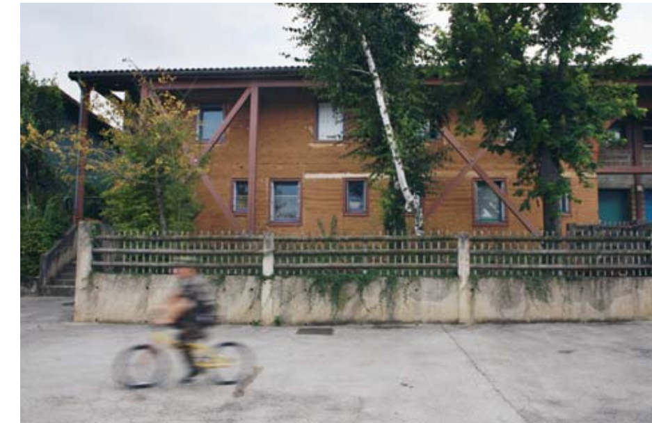
300 habitants sont logés dans l'ensemble de logements sociaux, inspirés des villes nouvelles nordiques comme Tapiola en Finlande. Architectes : F. Confino, S. Jaure et J-P. Duval.
