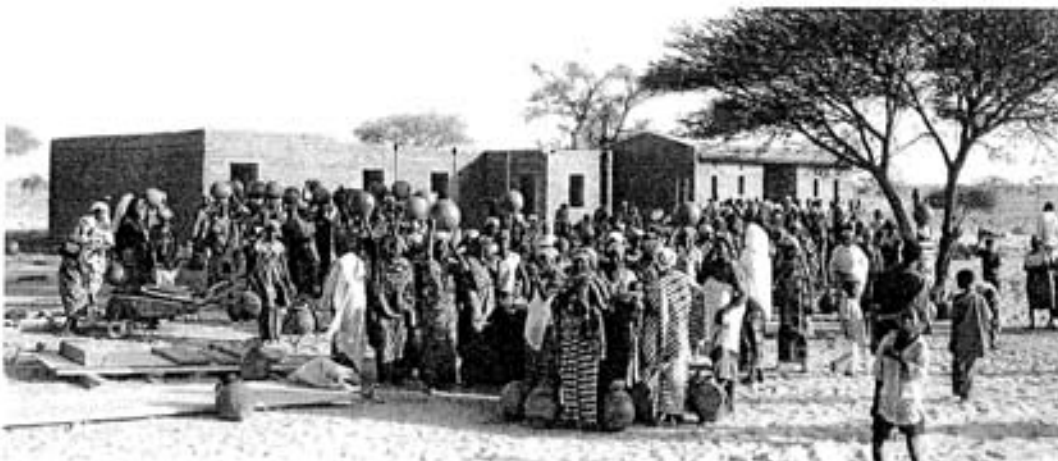
Dispensaire de Cake: toutes les constructions sont réalisées avec la participation active des villageois.
