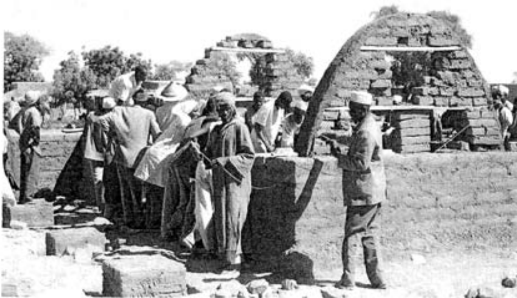
Les chantiers-formation sont un outil privilégié de la stratégie de diffusion. Ils permettent de confronter les innovations techniques à la fois aux professionnels et au public.
