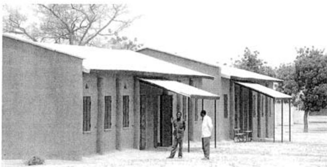
L'école de Kanem Bakatché: une démonstration très appréciée qui a inspiré la plupart des autres infrastructures construites durant le projet.
