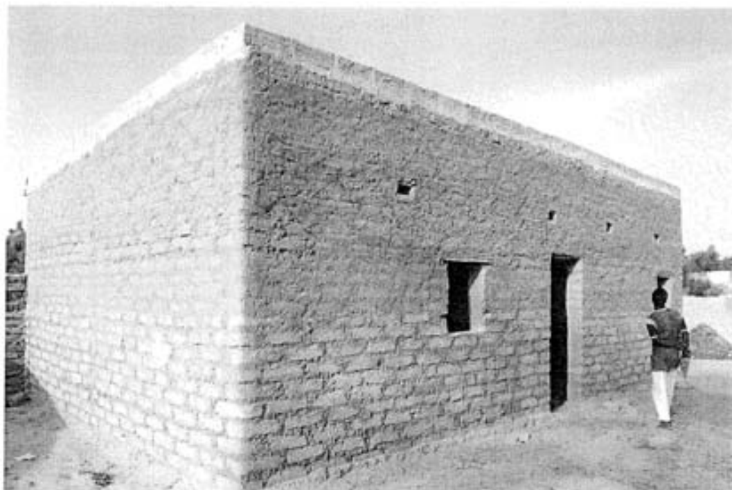
Bâtiment construit pour un privé à Mayahi reprenant plusieurs détails introduits par le projet
