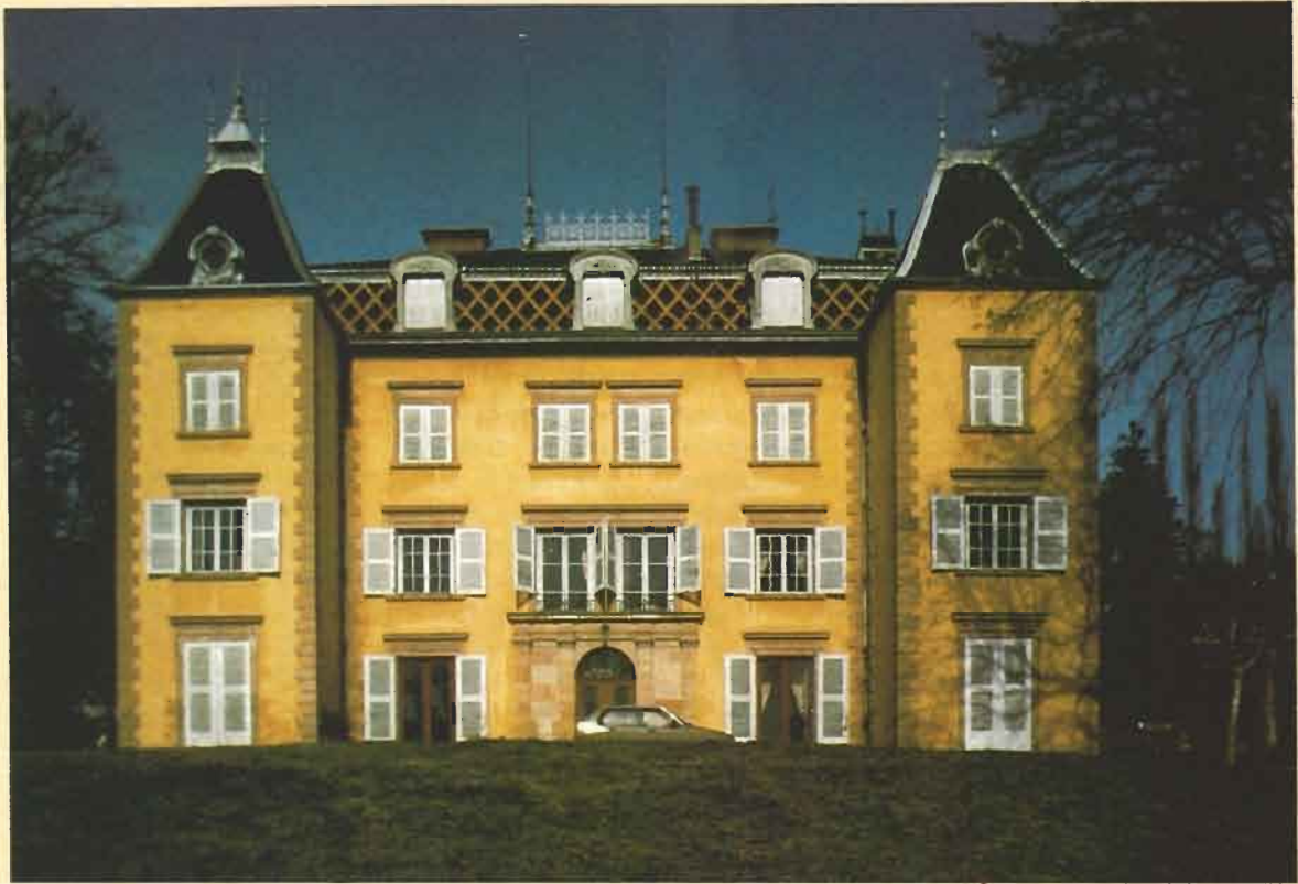
En haut : château édifié en pisé au XVIII e siècle dans la vallée de la Saône (Ain). Photo © Christian Lignon.
