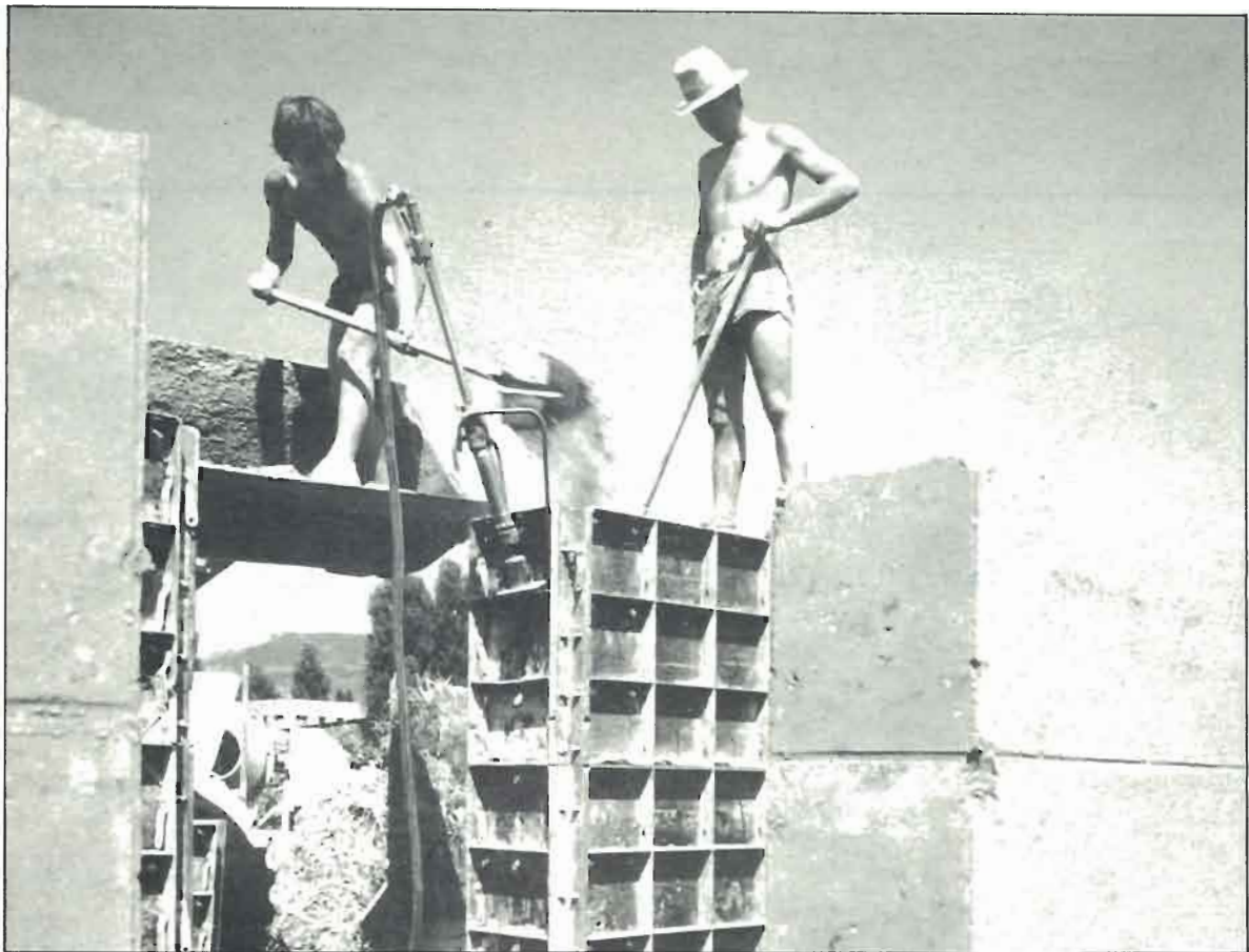
Pisé : En bas, chantier expérimental de mise en place du pisé au Centre scientifique et Technique du Bâtiment (CSTB) de Grenoble en 1985. Photo © CRATerre.
