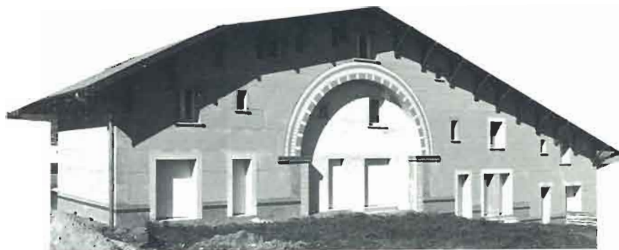
Immeuble de quatre logements sociaux édifié en pisé à l'Isle d'Abeau (1985) par l'architecte Odile Perreau-Hamburger. (Photo C. Lignon).
