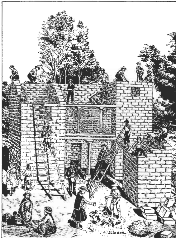
Chantiers utilisant l'adobe et le pisé dans les campagnes andines au Pérou. Illustrations © CRATerre.
