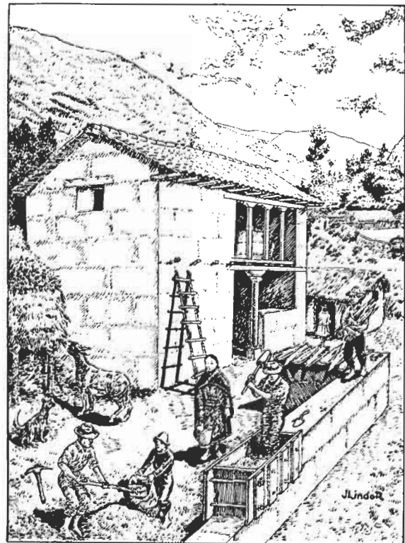
Chantiers utilisant l'adobe et le pisé dans les campagnes andines au Pérou. Illustrations © CRATerre.
