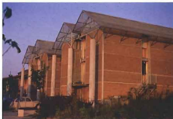
Un des projets du "Domaine de la Terre de l'Isle d'Abeau", sur la commune de Villefontaine (Isère)
