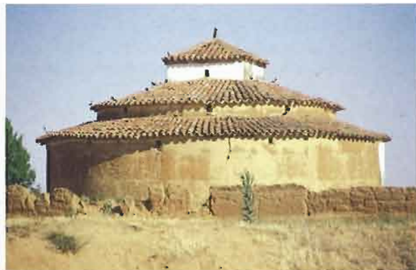
Pigeonnier en pisé (tapia) de forme ronde à anneaux concentriques, Nord de la région de Castille et León, Espagne
