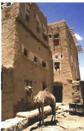
Habitat traditionnel du Yémen, région centre nord, en bauge et en briques de terres crues
