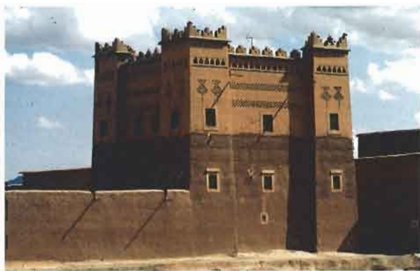
Kasbah traditionnelle en pisé (leuh) et briques crues d'adobe, dans la vallée du Drâa, sur du Maroc.
