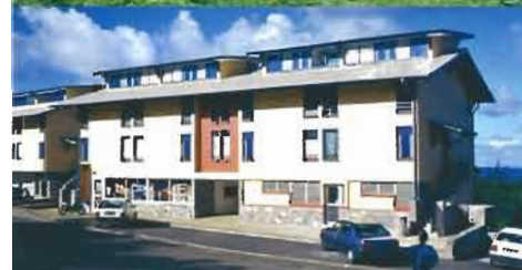
Divers bâtiments en blocs de terre comprimée, construits à Mayotte, commune de Passamainti (Grande Terre), en 1982 par l'équipe Craterre en appui technique à la Société immobilière de Mayotte
