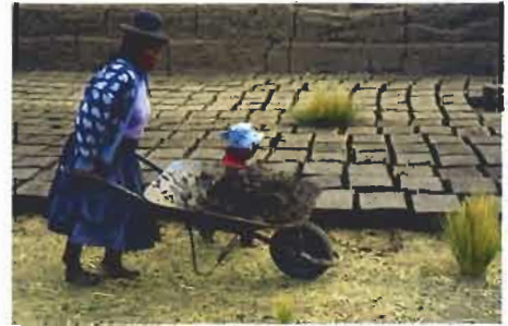
De droite à gauche 1. et 2. Préparation de la terre : on bat la terre avec les pieds et des pelles... 3. puis on l'achemine près de ceux qui travaillent au moulage des adobes. Derrière, les premières briques de la journée et celles de la veille. 4. Travail d'équipe. 5. La terre est compactée dans le moule avec les mains pendant que derrière on retire le moule. Travail en famille. 6. Lissage de la brique avant de retirer le moule. 7. Il retire le moule, la brique se tient bien. Photographies Irène Ducourtioux 1988
