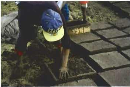
De droite à gauche 1. et 2. Préparation de la terre : on bat la terre avec les pieds et des pelles... 3. puis on l'achemine près de ceux qui travaillent au moulage des adobes. Derrière, les premières briques de la journée et celles de la veille. 4. Travail d'équipe. 5. La terre est compactée dans le moule avec les mains pendant que derrière on retire le moule. Travail en famille. 6. Lissage de la brique avant de retirer le moule. 7. Il retire le moule, la brique se tient bien. Photographies Irène Ducourtioux 1988
