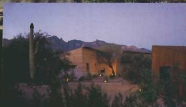
Les façades de terre, aux fondations en béton, conservent la fraîcheur au sein de la résidence et accompagnent la réception des visiteurs, vers un milieu plus hospitalier.
