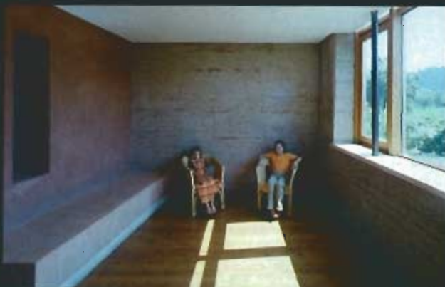
La surface lisse de la paroi et de la banquette permet de mettre en valeur la gamme très travaillée de couleurs et de grains du mur de terre conjoint.
