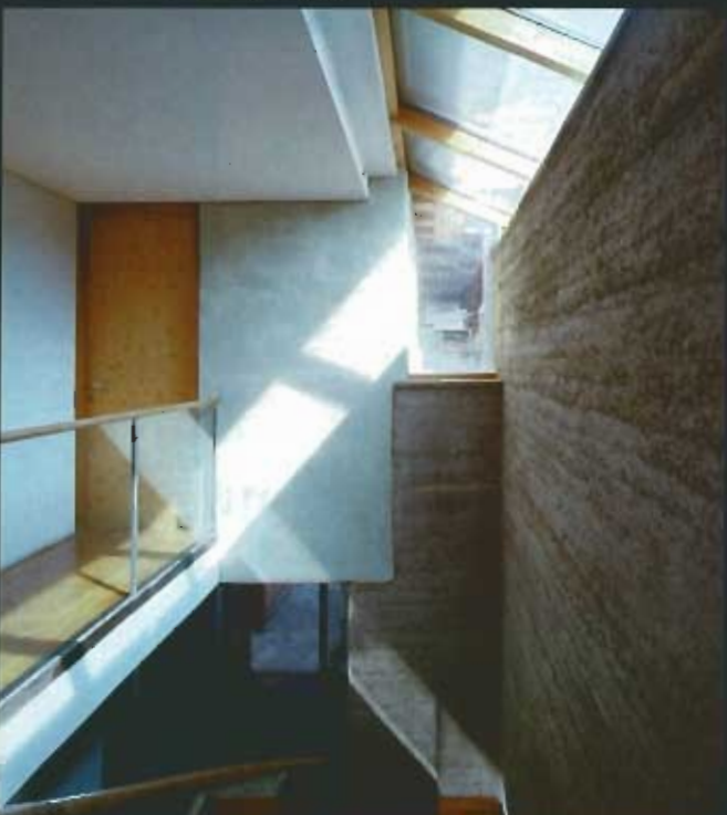
Une lumière zénithale se reflète sur le garde-corps pour valoriser les grains de la terre et briser la dimension imposante du mur porteur.
