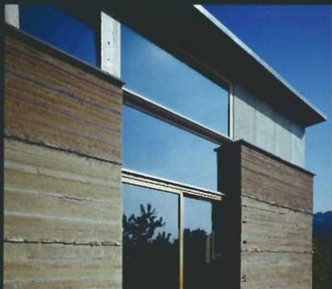
L'architecte a volontairement fait déborder la toiture pour compléter le système de protection.
