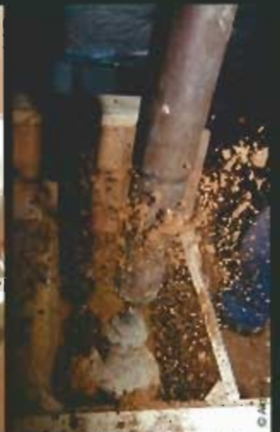
Création d'un mur en pisé : terre damée dans un coffrage à béton, avec un fouloir pneumatique ou une dameuse. Mise en œuvre d'un mur chauffant en pisé : tuyau déroulé, fixé à un mur porteur isolé avec des panneaux de roseaux.
