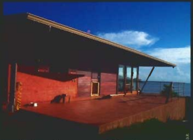
Les architectes ont opté pour une structure bois avec des essences locales : charpente en Ganfolo traité, poteaux de structure en amarante (bois de classe 3).
