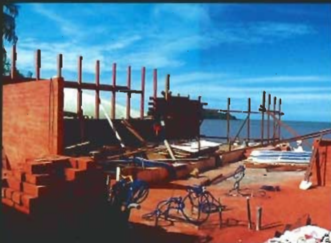
Réhabilitation d'une maison avec de la brique de terre comprimée stabilisée en Guyane, par les architectes Marie-Laure Drillien et Laurent Chamoux de l'agence Amarante. Les briques de terre sont produites selon la tradition guyanaise.
