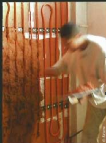
Création d'un mur en pisé : terre damée dans un coffrage à béton, avec un fouloir pneumatique ou une dameuse. Mise en œuvre d'un mur chauffant en pisé : tuyau déroulé, fixé à un mur porteur isolé avec des panneaux de roseaux.
