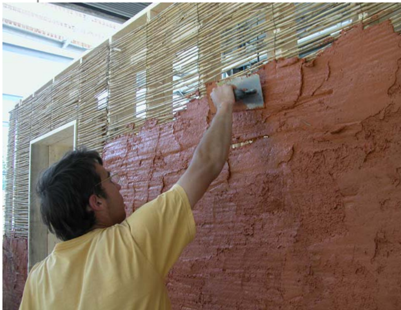
(Application d'enduit de terre « Tierrafino » sur coffrage perdu en canis _ Grains d'Isère 2004)
