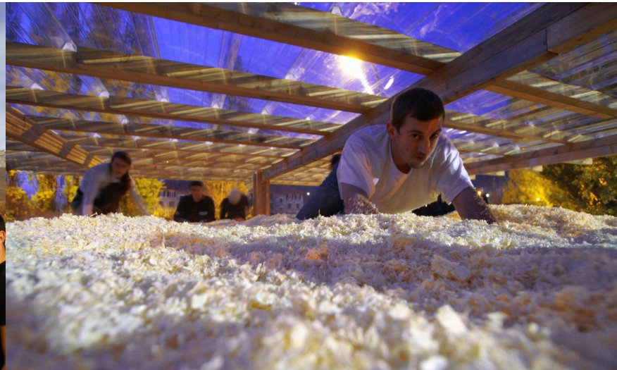
↑ Isolation du plancher et du plafond constituée de copeaux bois.
