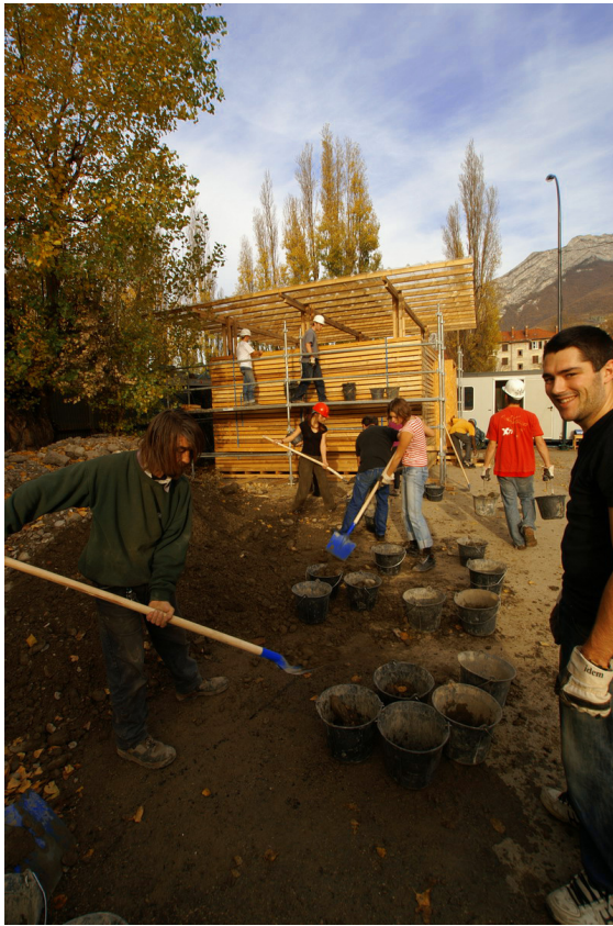
↑ Isolation du plancher et du plafond constituée de copeaux bois.
