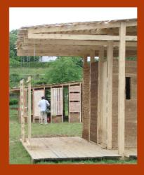
Le montage de la partie bois fut rapide car la technique du moisage est facile à mettre en œuvre. Tous les éléments de l'ossature ont été montés et assemblés en trois jours.
