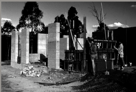
Panneaux verticaux (murs «trumeaux»)
