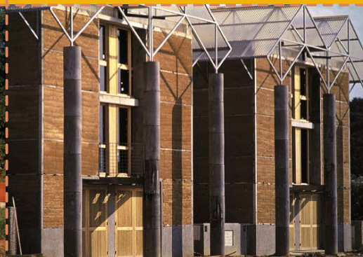
Le Domaine de la Terre, HLM, Villefontaine - France Architecte: G. Perraudin & F. Jourda
