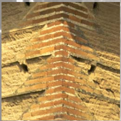
Chainages d'angle - en briques cuites appareillées - en machefer.
