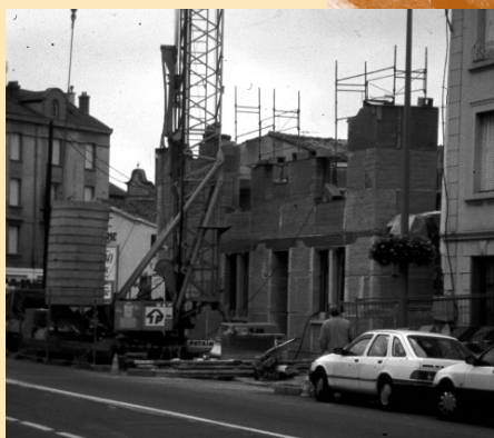
Le pisé actuel pisé préfabriqué, maison à Montbrison, réalisation N. Meunier
