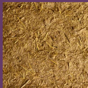
Différents traitements du mur en pisé avant la pose d'un enduit de finition reliefs «piqués» pour améliorer l'accroche de l'enduit, grillage en armature (pour enduits «durs»), enduits plus ou moins grossiers avec fibres
