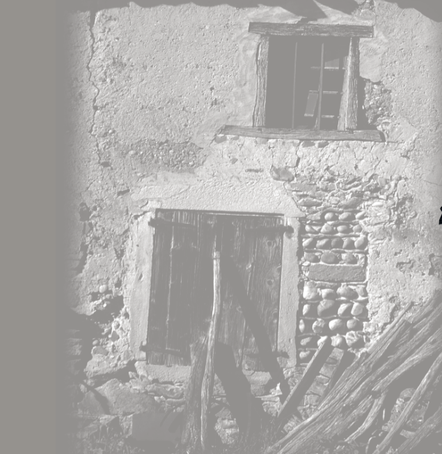
Tirants et clés de bois assurant le chaînage des murs.
