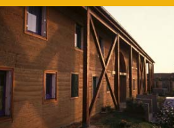
Le Domaine de la Terre, HLM, Villefontaine, France. Architecte: S. Jauré
