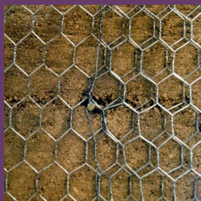
Différents traitements du mur en pisé avant la pose d'un enduit de finition reliefs «piqués» pour améliorer l'accroche de l'enduit, grillage en armature (pour enduits «durs»), enduits plus ou moins grossiers avec fibres
