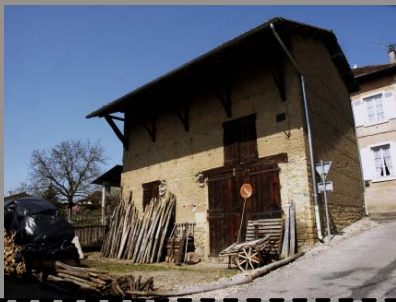
Grange à St-Savin. La toiture à 2 pans possède un grand débord de toiture sur consoles.
