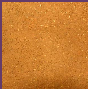
Différents traitements du mur en pisé avant la pose d'un enduit de finition reliefs «piqués» pour améliorer l'accroche de l'enduit, grillage en armature (pour enduits «durs»), enduits plus ou moins grossiers avec fibres
