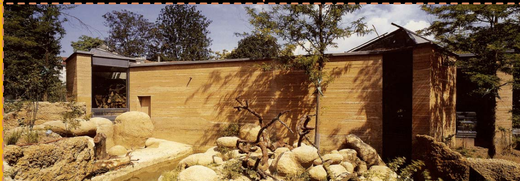
Villa privée en Allemagne Réalisation: Martin Rauch
