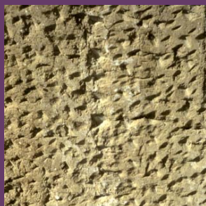
Différents traitements du mur en pisé avant la pose d'un enduit de finition reliefs «piqués» pour améliorer l'accroche de l'enduit, grillage en armature (pour enduits «durs»), enduits plus ou moins grossiers avec fibres
