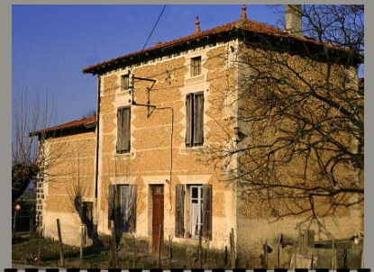
Maison du début du XXe siècle. Chainages d'angle et tableaux de baie sont réalisés en béton.
