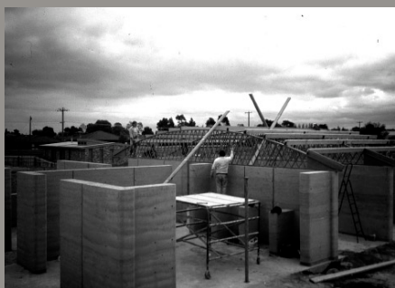
Eléments autoporteurs indépendants en forme de «T», de «L»
