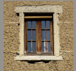
linteau et jambages en pierre de molasse
