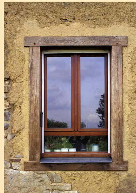
La reprise ou création de nouvelles ouvertures dans des murs en pisé peut actualiser le principe des cadres massifs en bois généralement posés en parement extérieur.
