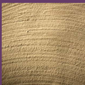
Différents traitements du mur en pisé avant la pose d'un enduit de finition reliefs «piqués» pour améliorer l'accroche de l'enduit, grillage en armature (pour enduits «durs»), enduits plus ou moins grossiers avec fibres
