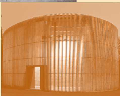
Chapelle du Versöhnung, Berlin Réalisation : Martin Rauch - Allemagne
