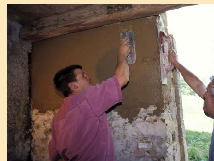
Une entreprise régionale, AKTerre, réactualise la pratique des enduits muraux en terre et paille. Ces matériaux sont diffusés sur le marché régional, en sacs, prêts à l'emploi.
