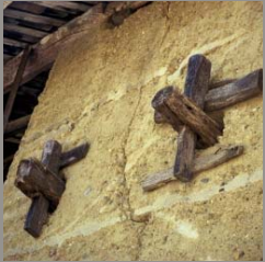
Tirants et clés de bois assurant le chaînage des murs.
