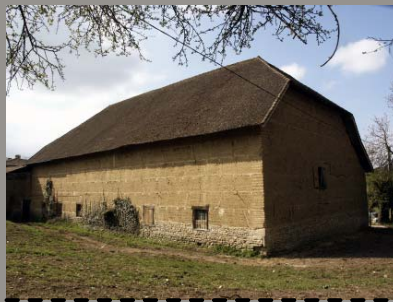
Ferme à Moncarra. Les angles sont renforcés par des lits de chaux à chaque banchée.
