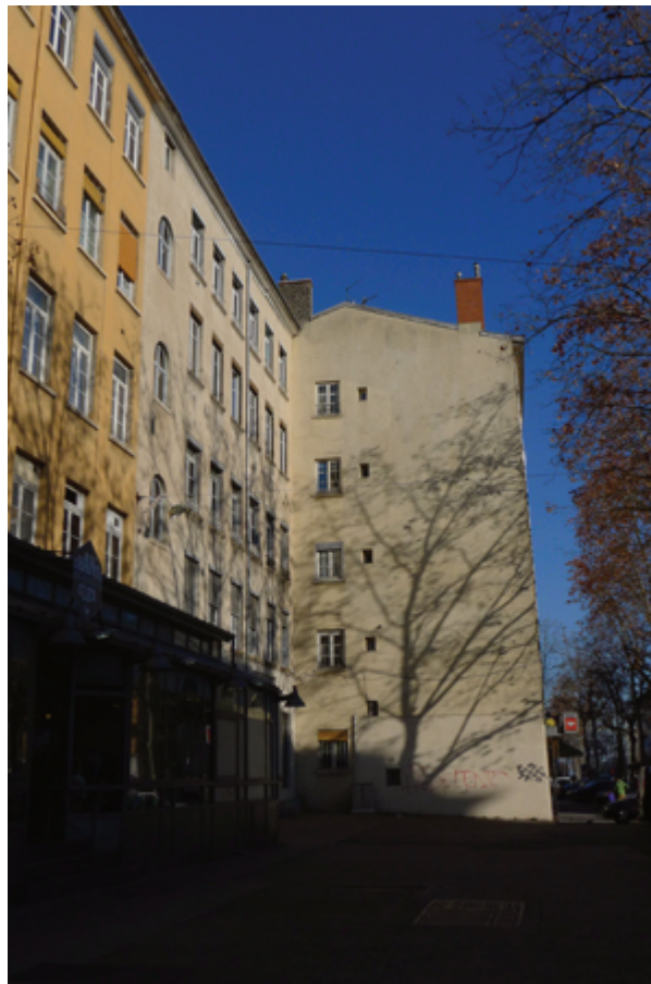
Immeuble canut de grande hauteur dont le mur de refend est en pisé de terre tandis que la façade principale est en pierre, 155 boulevard de la Croix-Rousse, Lyon 69004, © Anne-Sophie Cléménçon, 2015.
