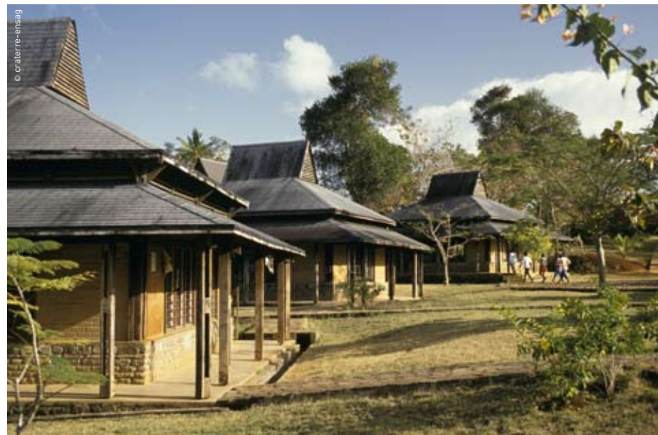
Hameau rural réalisé par l'architecte Léon Attila Cheyssial avec les artisans de la coopérative d'usagers-bâisseurs Musada (« travailler ensemble ») initiée et animée par le CRAterre, en liaison avec la Société immobilière de Mayotte. De tels ensembles ont été édifiés en terre crue à travers toute l'île de Mayotte (océan Indien). Vu son succès et son efficacité, cette logique d'auto-construction encadrée de l'habitat social a été généralisée par le CRAterre dans divers autres pays d'Afrique.
